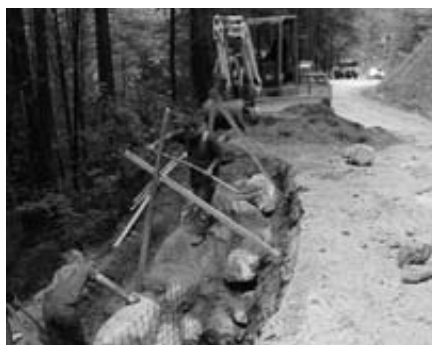
Izdelava opornega zidu na cesti Volča-Lom
