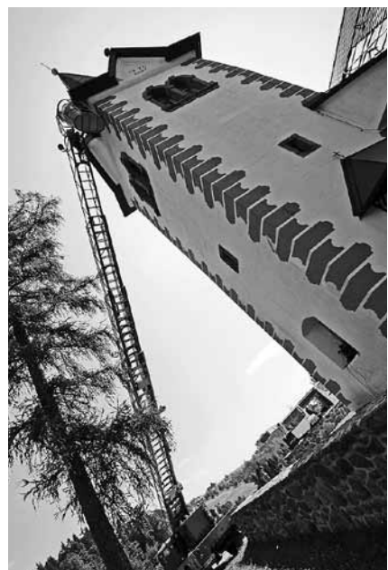
Obnova žlebov na cerkvi na Gabrški Gori
