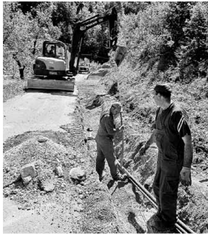
Gradnja vodovoda v Hotoveljski grapi
