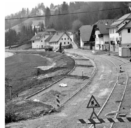
Izgradnja varnega odseka od šole do središča Poljan
