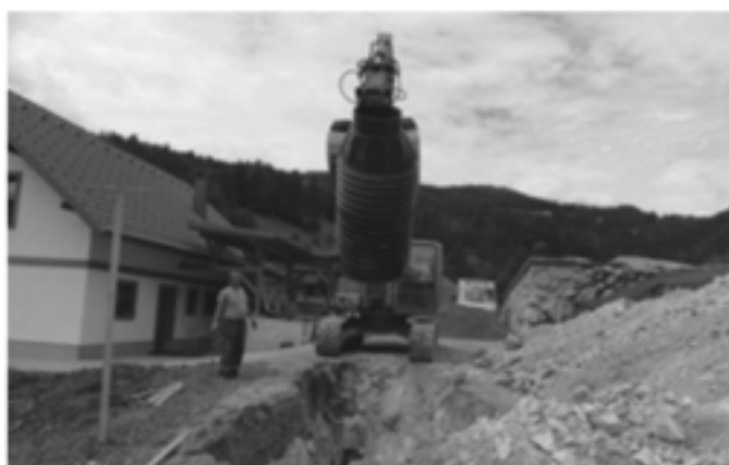
Zaradi dolomitne podlage je bila gradnja zahtevna.
