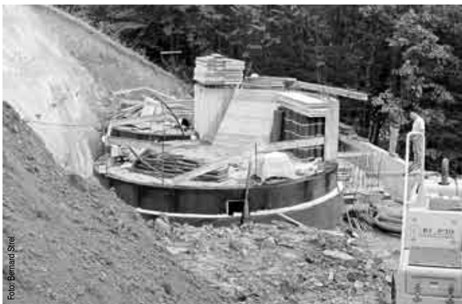
Gradbeno so zaključeni vsi objekti, razen vodohrana Kovnica, kjer so bila dela zelo zahtevna zaradi strmega terena in nestabilne zemljine.
