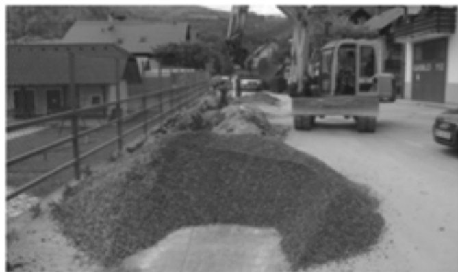
Gradnja kanalizacije na Trebiji.
