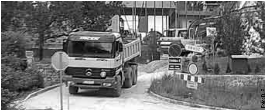
Na Trebiji so kanalizacijo že gradili konec 90-ih.
