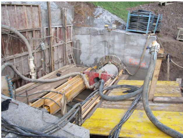
Zahtevna izvedba mikrotunelinga v dolomitni podlagi pod regionalno cesto v Gorenji vasi.
