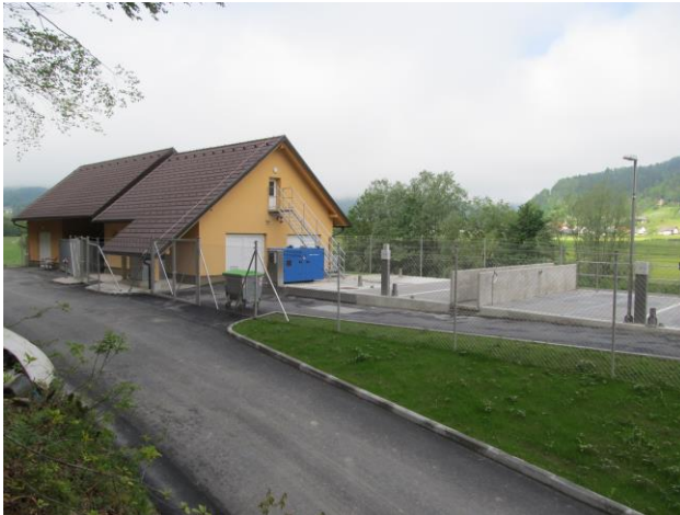
Prenovljena upravna stavba in stari biološki blok.
