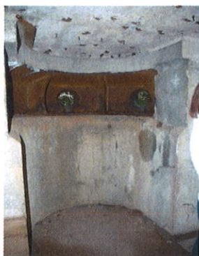
Strelne line v vršnem bunkerju (foto: Saša Renčelj Š., 2008)
