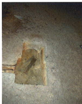
Ustje cevi za odvodnjavanje hribinske vode (foto: Saša Renčelj Š., 2008)
