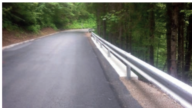
Obnovljen spodnji odsek
