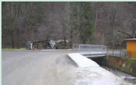
Obnova mostu pri Klovžarju
