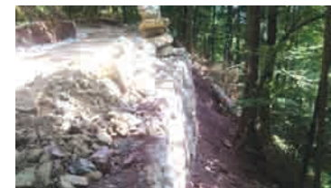
Sanacija usada Laniše
