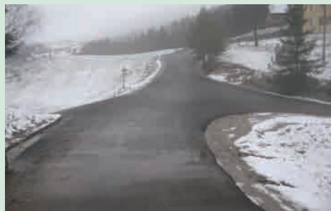
Obnova javne poti Studor - Leskovica
