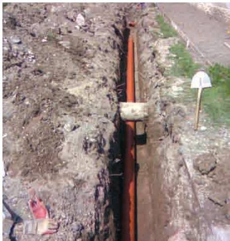
Hišni priključek na kanalizacijo na območju Gorenje vasi
