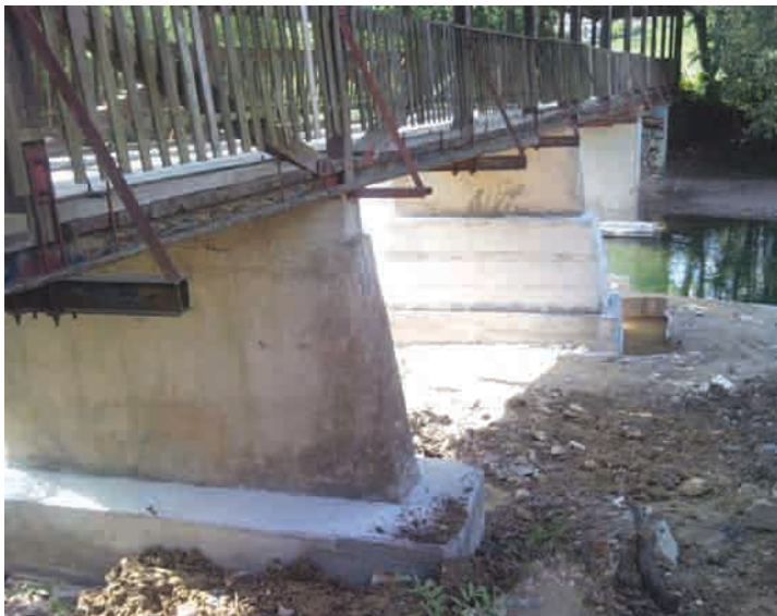
Sanacija mostu Žabja vas
