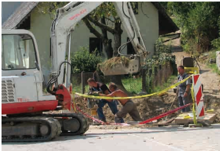
Gradnja širokopasovnega omrežja
