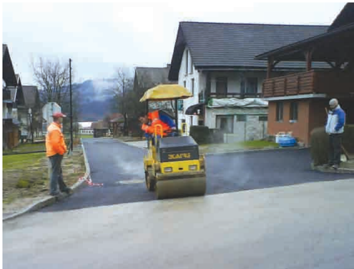
Asfaltiranje ceste na Trati
