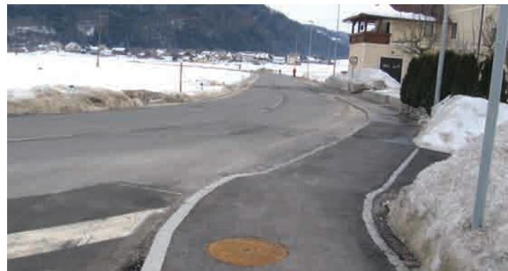
Cesta in pločniki krožišče po rekonstrukciji
