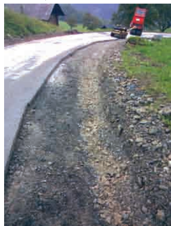
Sanacija LC Zapreval
