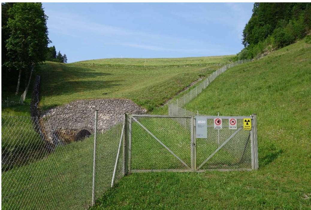
Slika1: Pogled na odlagališče Jazbec. Viden je prepust pod odlagališčem ter drenažni jarek na levi pod gozdom in na desni ob ograji.
