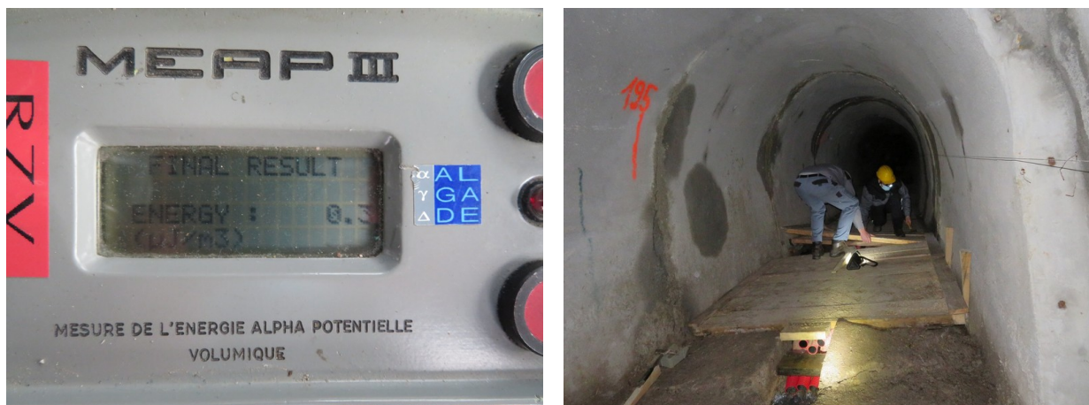
Slika 5: Meritev delovnih pogojev pred vstopom v drenažni rov in sanacija poškodb na mestu prehoda drenažnega rova skozi drsino plaz
