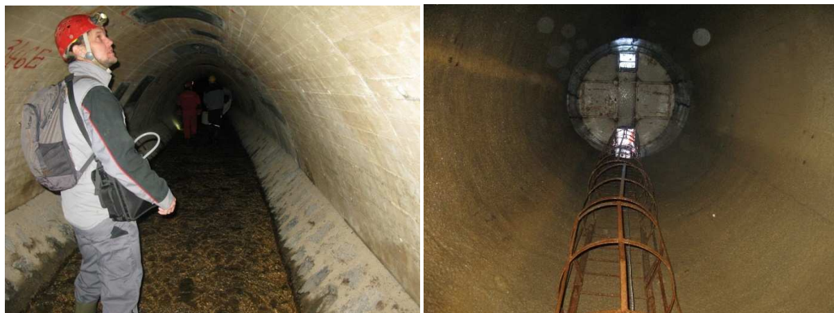
Slika 3: Ogled prepusta pod odlagališčem Jazbec (levo), pogled iz drenažnega jaška proti površju (desno).
