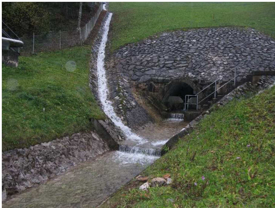
Slika 2: Vtok vode po jarkih 1 in 2 in iztok iz prepusta pod odlagališčem v kanal Jazbec po obilnejših padavinah (november 2019).
