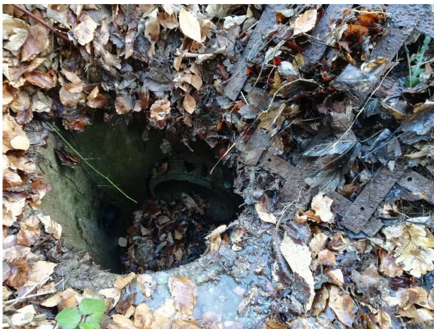
Slika 11: Vtočni objekt s kovinsko rešetko na vodotoku 2 in viden vtok v BC Ø40cm.
