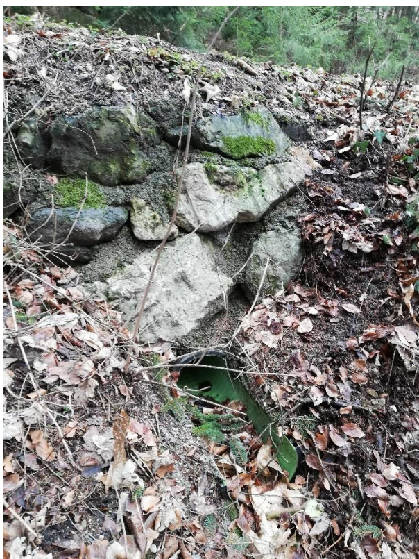
Slika 24: Iztočna odprtina plastična cev Ø30cm.
