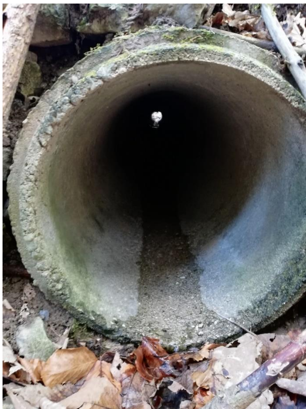
Slika 20: Iztočna odprtina BC Ø40cm.
