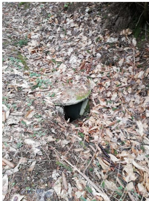
Slika 22: Vtočna odprtina na cestnem požiralniku, kamor se steka vodotok 5.
