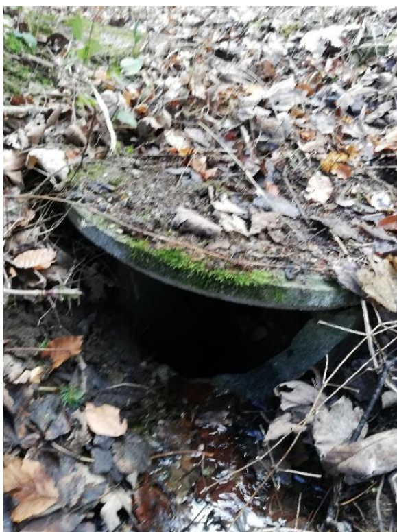
Slika 16: Cestni požiralnik na prepustu V3 z vtočno odprtino elipsaste oblike.
