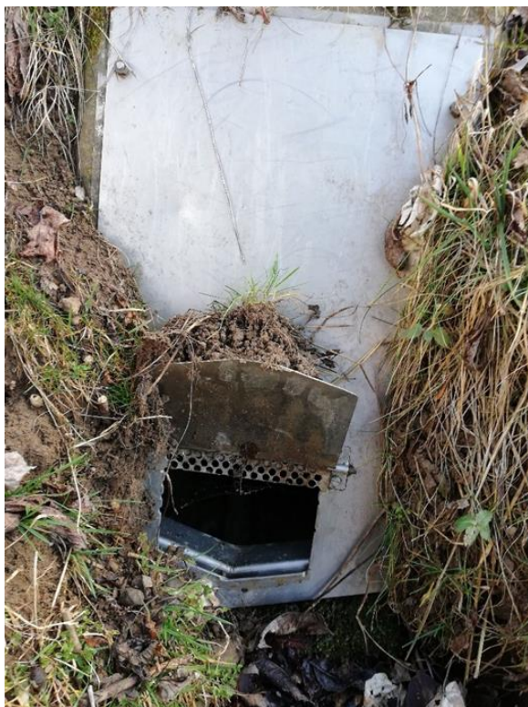
Slika 15: Objekt, za katerega sklepamo, da je razbremenilnik.
