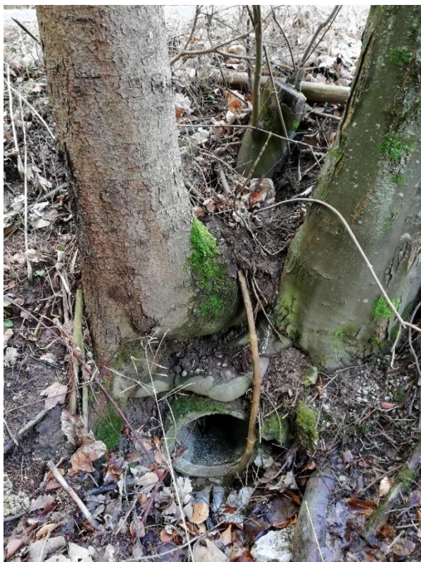
Slika 19: Vtok v prepust V4 z odprtino BC Ø30cm.
