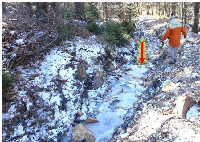
Sliki 7, 8: Izgubljanje vode v kanalu, peto območje. Mesto izgubljanja je označeno s puščico. Desno jarek na travniku nad h.št. Laze 11 za odvod vode.
