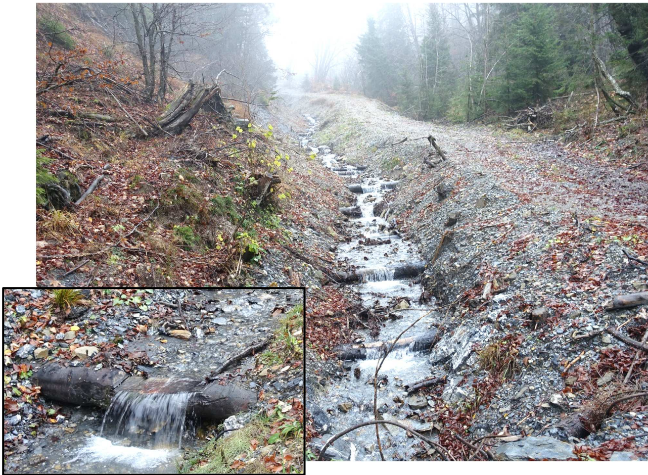
Slika 2: Ureditve struge potoka v Slugovi dolini, pogled proti severu, gorvodno. V strugi so položeni umirjevalni pragovi. Levo detajl umirjevalnega praga. Desno od urejene struge je servisna pot.
