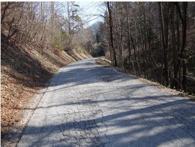
Sliki 3, 4: Levo poškodovano cestišče ob potoku Zakrajščica, pogled proti severu. Desno razpoka v cestišču na območju med 2,815 in 2,940.
