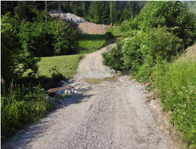
Slika 21: Obstoječ prepust, pogled iz levega bregu
