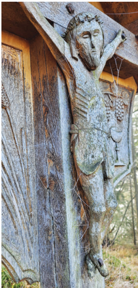
Križ po dvajsetih letih, potreben obnove (Foto: Goran Šušnjar)
