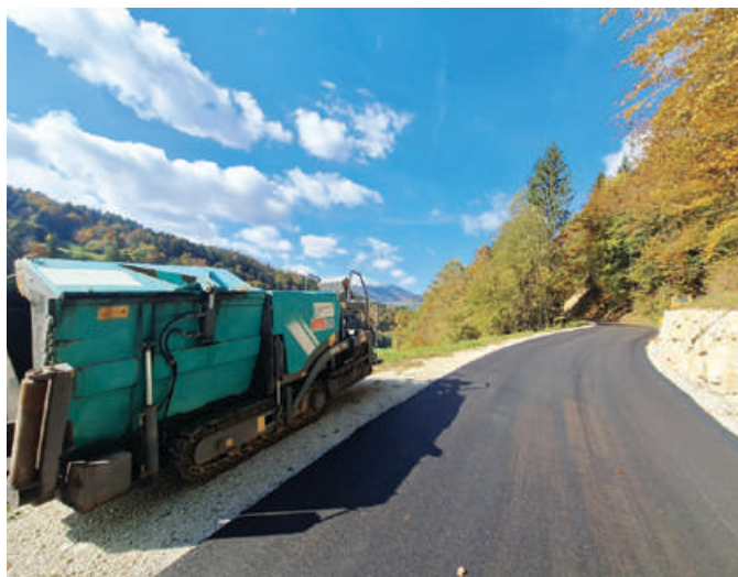
Asfaltiranje ceste Poljane–Smoldno (Foto: Anton Debeljak)
