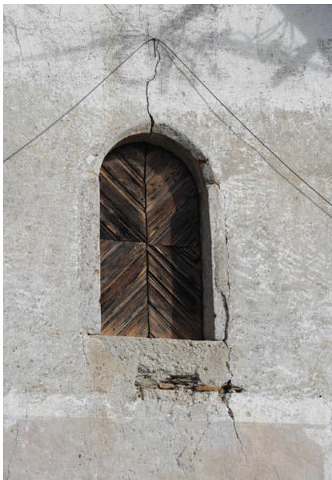
Polkrožni kamniti portal s posnetimi robovi v zatrepu južne fasade Županovša, pred barokizacijo v drugi polovici 18. stoletja vhodni portal hiše.
