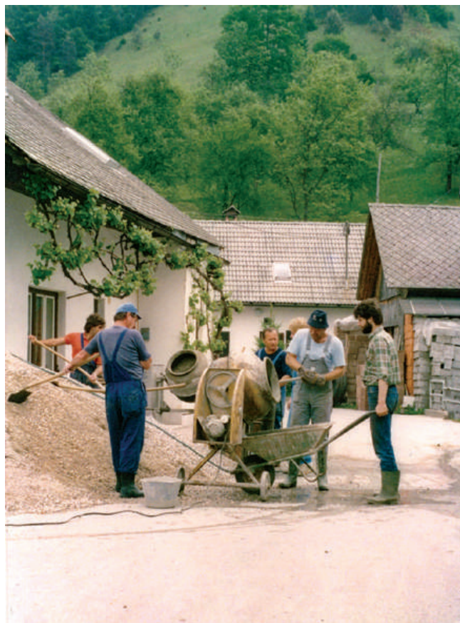
Mešanje betona za zalivanje plate (Foto: Tadeja Šubic)
