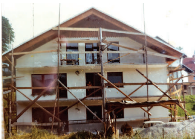
Gradbeni oder in izdelava fasade na spodnji ulici (Foto: Miro Stanonik)
