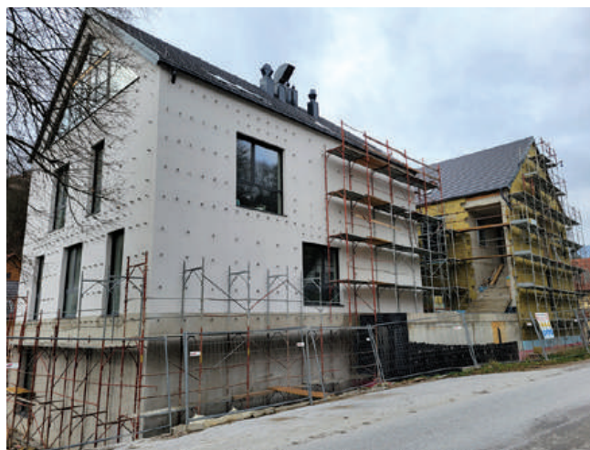
Novi kulturni dom v gradnji (Foto: Jaka Šubic)
