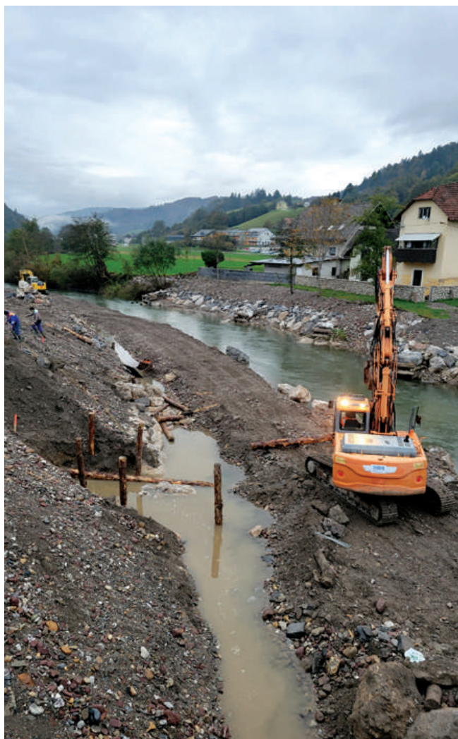
Sanacija po poplavah (Foto: Jaka Šubic)
