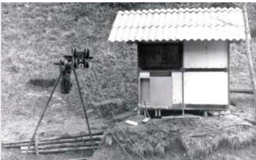
Gradnja vlečnice na Golavi
