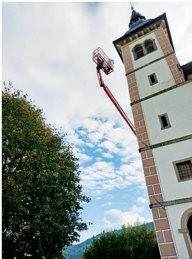
Obnovitvena dela na fasadi zvonika na cerkvi sv. Volbenka
