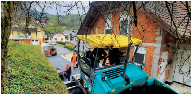
Asfaltiranje ceste v Hotovlji, odcep Kočar–Bolantač–Žnidarčk
