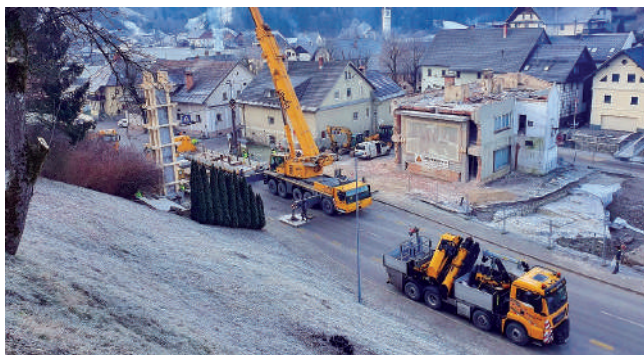
Priprave na prestavitev freske in kamnitega stebrenika (Foto: Jaka Šubic)
