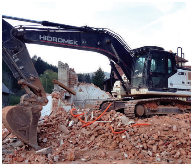
Zidarstvo Božnar gradi in ruši. (Foto: Goran Šušnjar)
