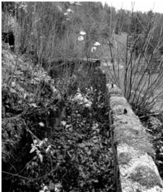
Elektrarna, zadnji del dovodnega kanala. (Foto: Alojz Demšar, november 2019)
