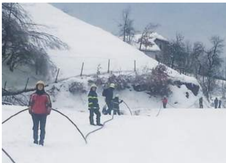
Polaganje električnega kabla od Fužin do Sela pri Žireh v času žledoloma leta 2014
