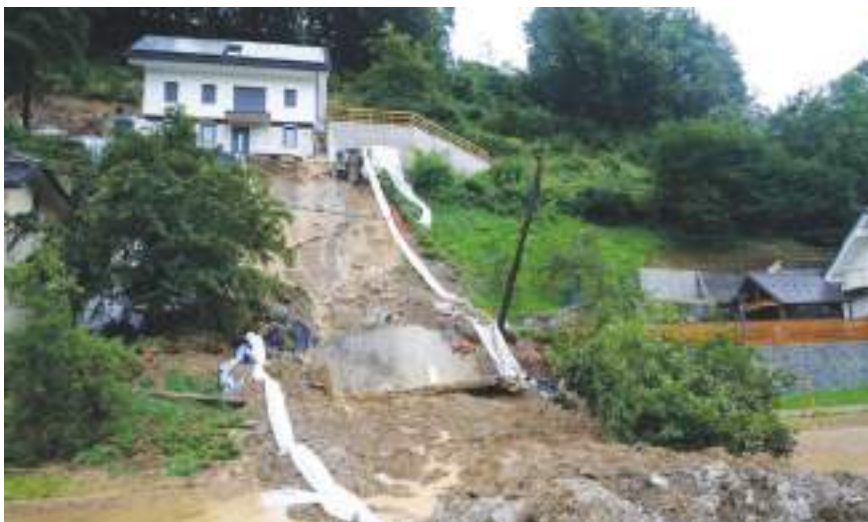
Pod hišo družine Šega se je sprožil drugi plaz in s sabo odnesel škarpno z vso inštalacijo.
