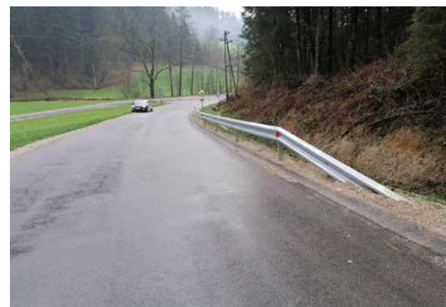
Obnova ceste Javorje
