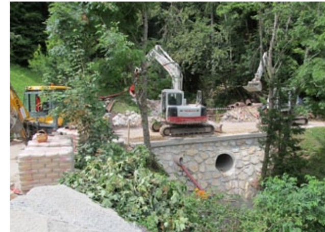
Sanacija petih lokacij v Žirovskem Vrhu
