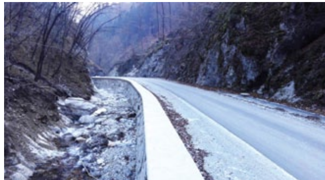
Sanacija ceste Podpleče
