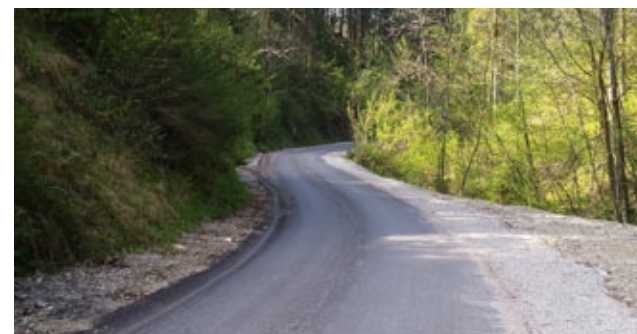
Novozgrajeni cestni odsek
