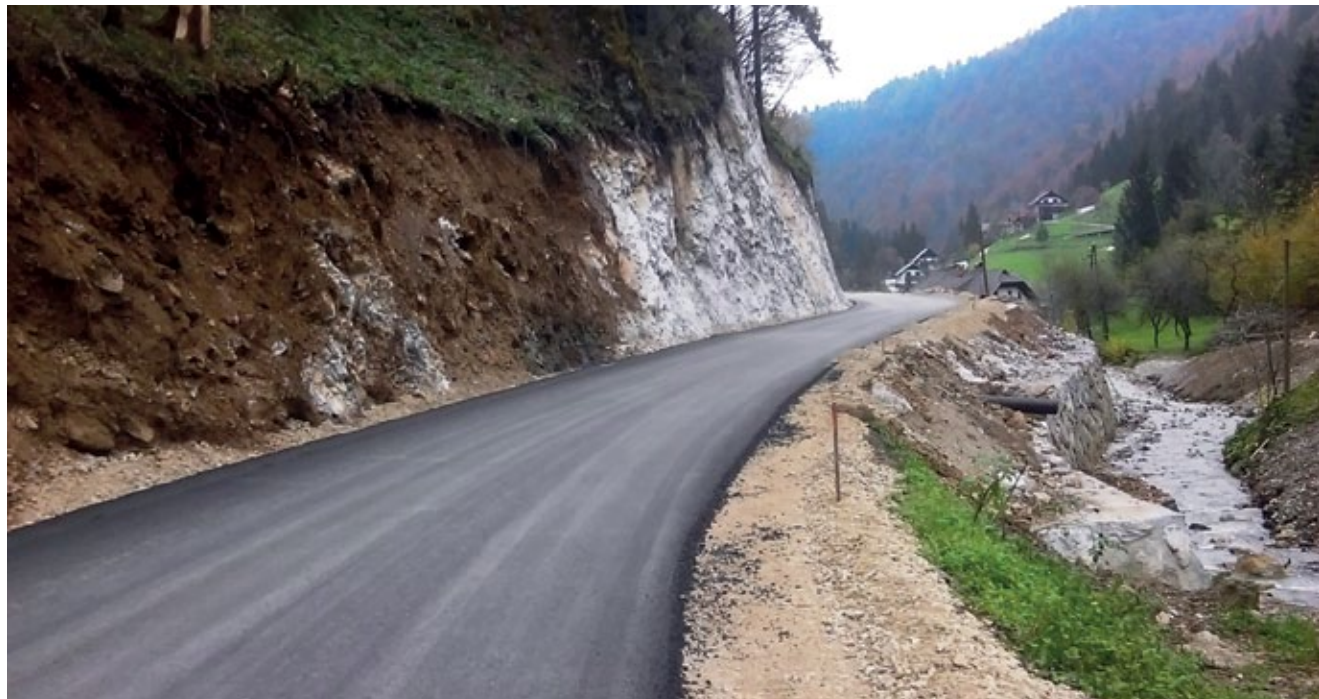
Obnova ceste Hotovlja
