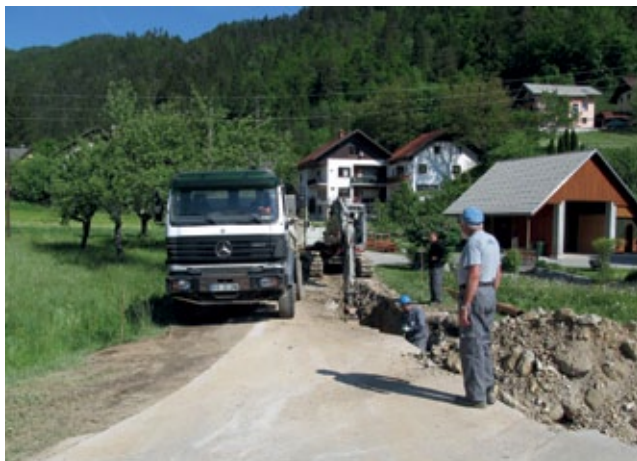
Gradnja kanalizacije v Podgori
