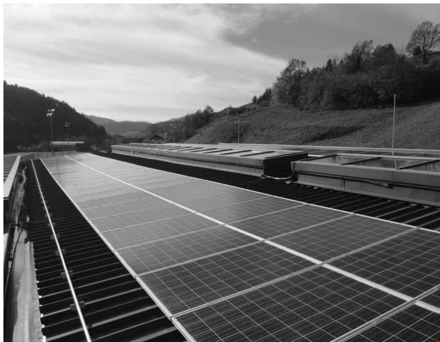
Zbiralniki sončne energije na strehi OŠ Poljane
