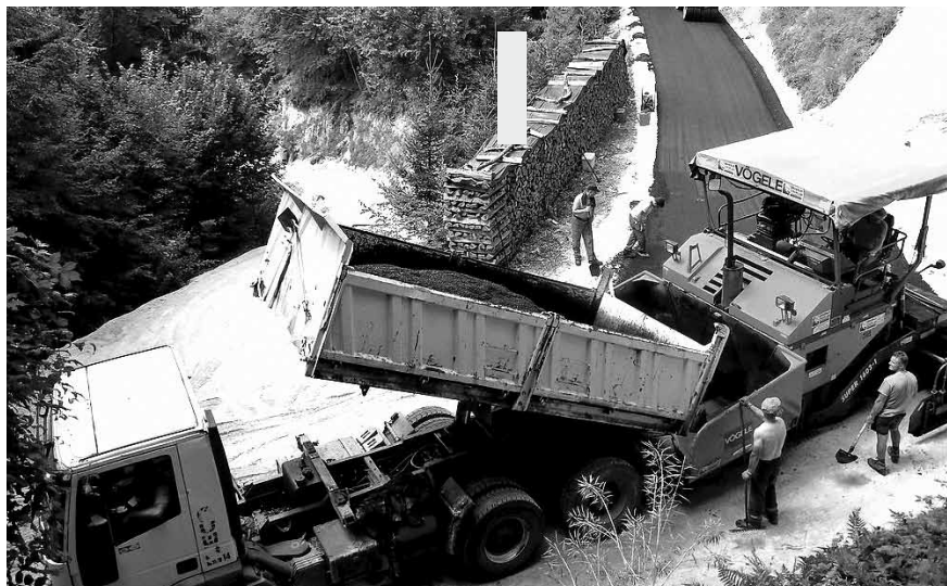
Asfaltiranje ceste na odcepu Hotovnk – Planinčar
