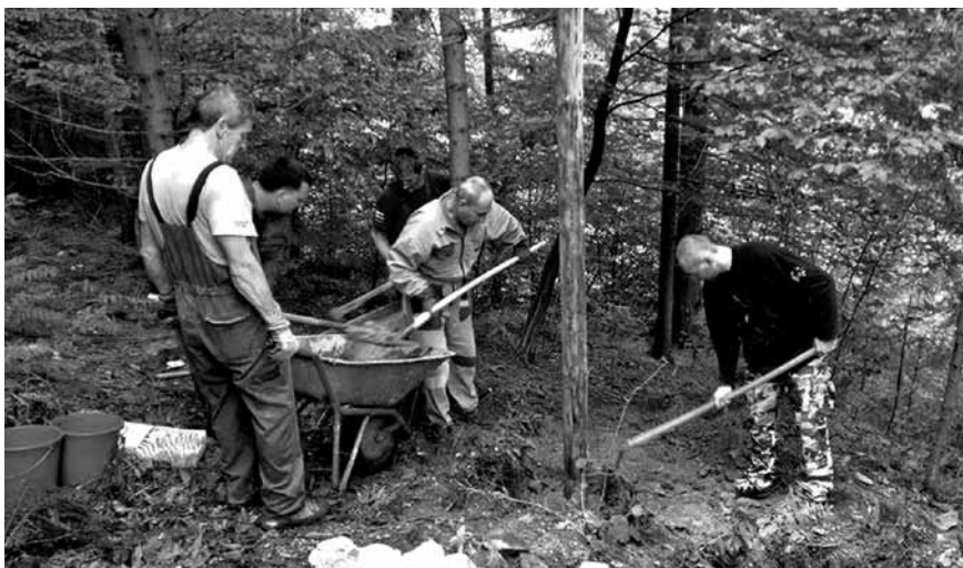
Postavljanje temeljev za trim stezo
