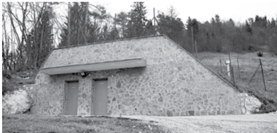
Novozgrajeni vodohran na Trebiji
