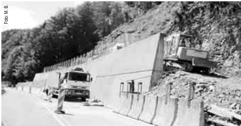
Brežina bo zavarovana z globoko sidranimi mrežami.
