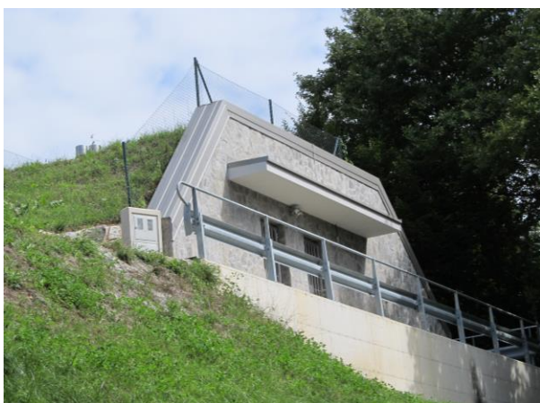
Vodohran Kovnica kapacitete 100 m 3
