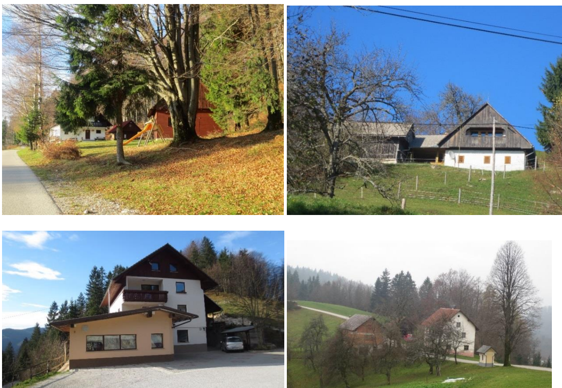
Primeri: Primeri neustreznih izvzemov zazidanih stavbnih zemljišč
