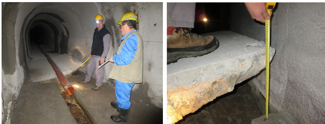
Slika 5: Prehod drenažnega rova skozi plazino, dvig betonske talne obloge
