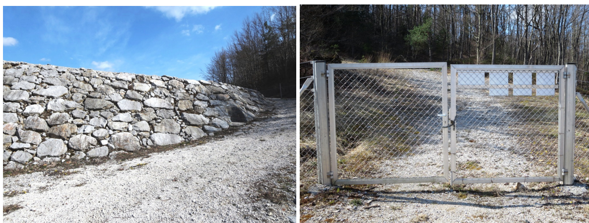
Slika 5: Skalometna peta na J robu odlagališča (zraven MM ZDZ, levo), premiki vidni na vhodnih vratih (desno)
