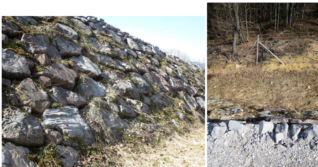
Slika 9: Skalometna peta kaže spremembe na širini nekaj metrov (levo), pogled s ceste preko skalometne pete proti gozdu, za ograjo na desni strani stebra viden posedek na robu plazu od leta 1991 dalje (desno).
