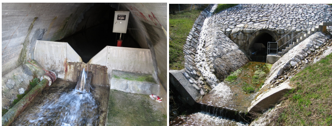
Slika 16 : Merilno mesto Jazbec na spodnjem ustju propusta pod odlagališčem Jazbec (levo), točka mešanja voda v kanalu Jazbec, levo jarek 1, v sredini propust odlagališča z merilnim mestom Jazbec, desno jarek 2
