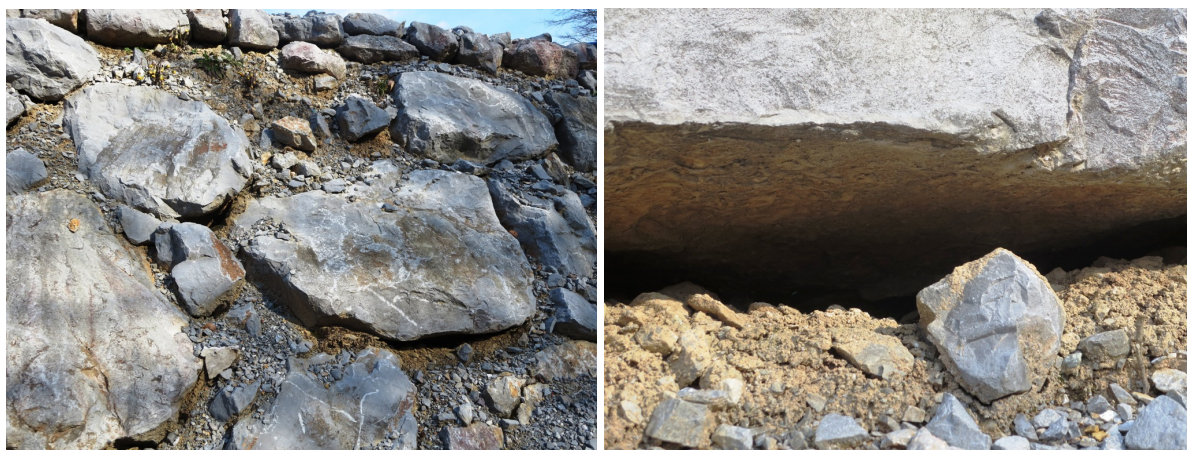
Slika 6: Premiki v skalometni peti (slika 5, levo)
