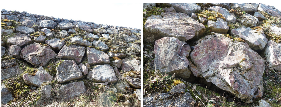
Slika 8: Severna skalometna peta, mesto prehoda ceste (slika 7, levo) preko roba plazu (levo), spremembe v skalometni peti (desno)
