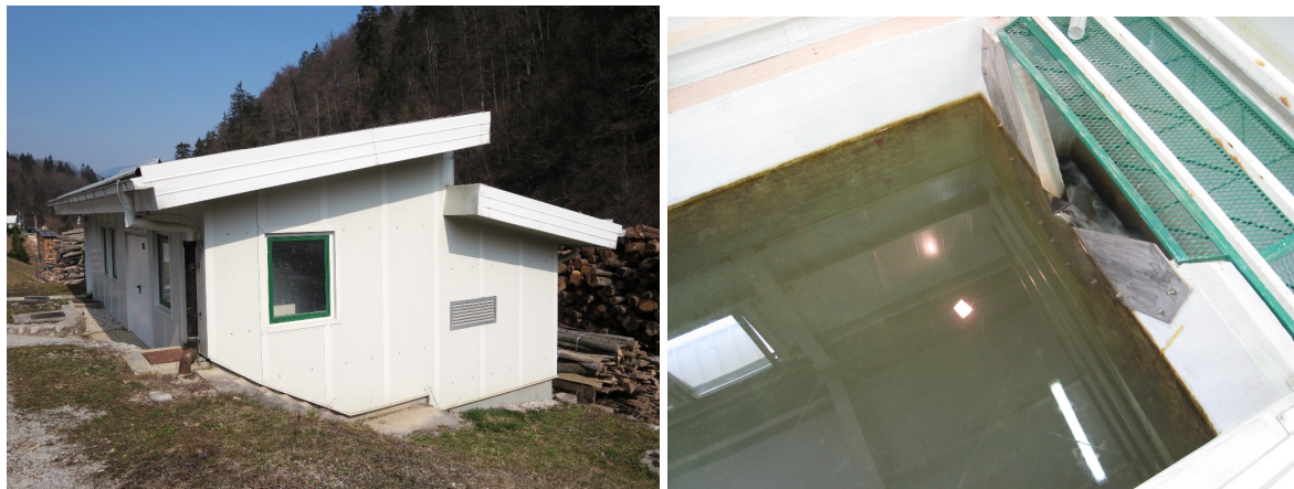
Slika 15: Merilno mesto JV-P-10 za meritev pretoka iztoka jamske vode skozi podkop P-10 v potok Brebovščico (levo),
