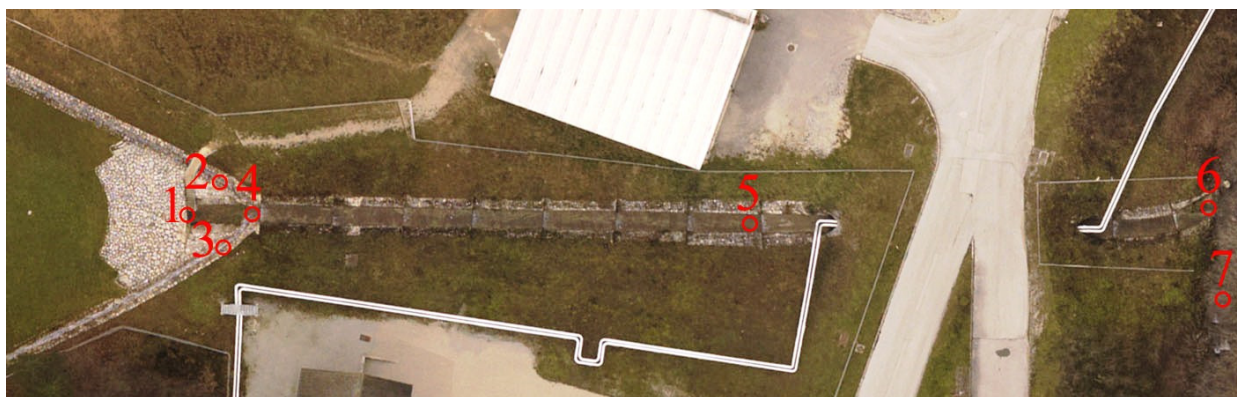
Slika 17: Objekti za odvod voda odlagališča Jazbec: 1 – propust odlagališča, 2 – jarek 2, 3 – jarek 1, 4 – točka mešanja, 5 – MM Kanal Jazbec, 6 – izliv tekočega izpusta odlagališča v potok Brebovščico, 7 – potok Brebovščica; bela črta ob kanalu je varnostna ograja odlagališča Jazbec
