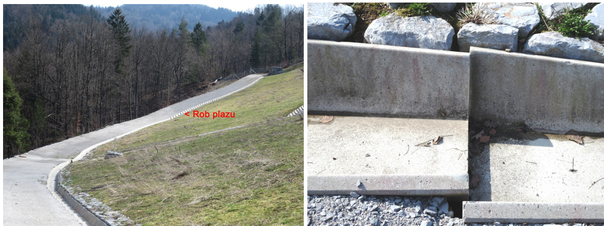
Slika 7: Severna skalometna peta, mesto prehoda preko roba plazu (levo), razmik kanalet (desno)
