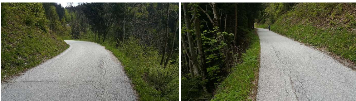
FOTO 11 in 12: Usad v nasipu v km 2.380
