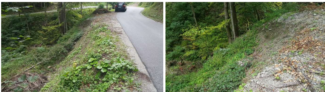
FOTO 9 in 10: Usad v nasipu nad potokom v km 2.200
