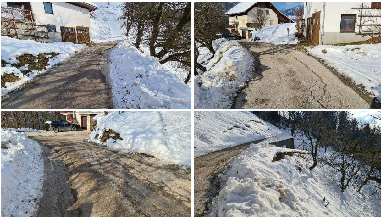
FOTO 1 -4: Posedanje zunanjega dela cestišča - PLAZ 1 (prečna prereza P2 in P3)
