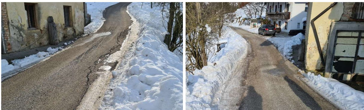
FOTO 7 in 8:Plaz 3 je formiran v podaljšku spodnje grape in hkrati v območju zatekanja meteornih voda iz cestišča
