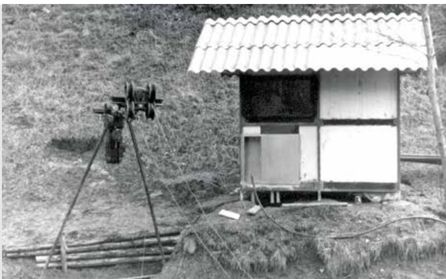
Gradnja vlečnice na Golavi
