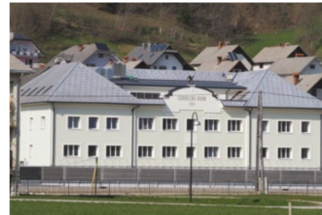
Energetska in statična sanacija KD Gorenja vas
