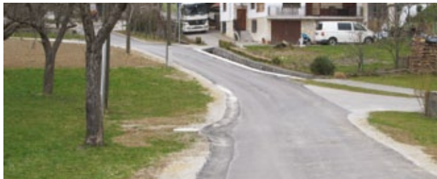
Na novo asfaltirana cesta v Podgori
