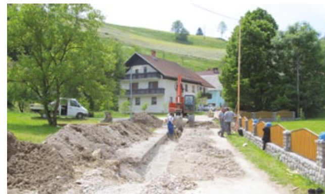
Gradnja sekundarnega kanala v Podgori
