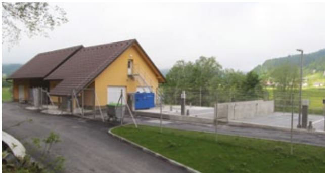
Stari biološki blok in upravna stavba čistilne naprave Gorenja vas
