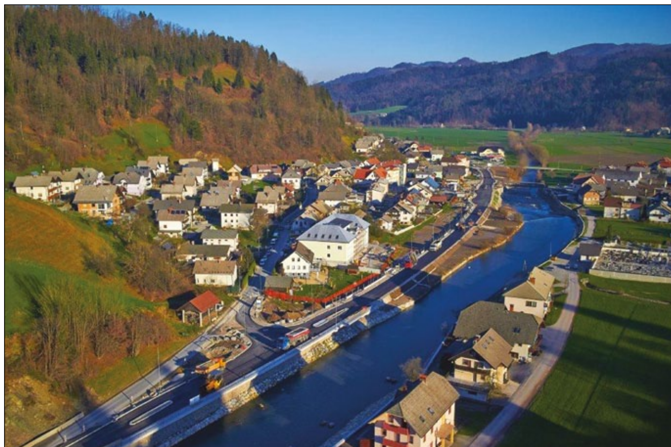
Obvoznica Gorenja vas – asfaltiranje obvoznice (Vir: Arhiv Marpi, d. o. o.)
