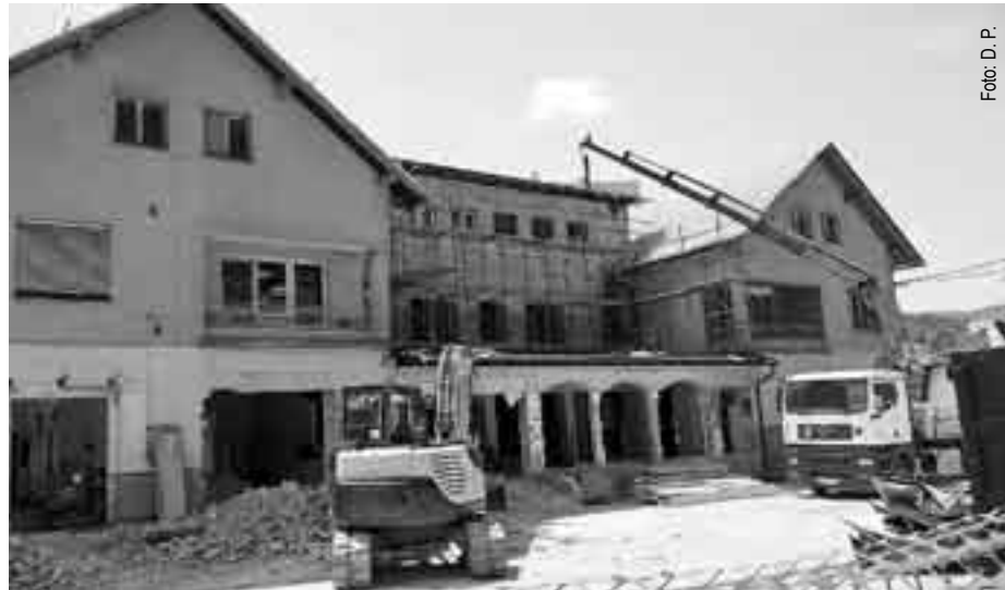
Z junijem so se na stavbi, v kateri je bila trgovina KGZ Škofja Loka, pričela obnovitvena dela.
