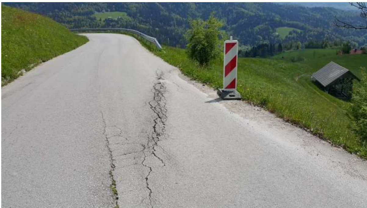
FOTO 7: Plaz 4. Viden odlomni rob v asfaltu. Maksimalni posedek več kot 20 cm.
