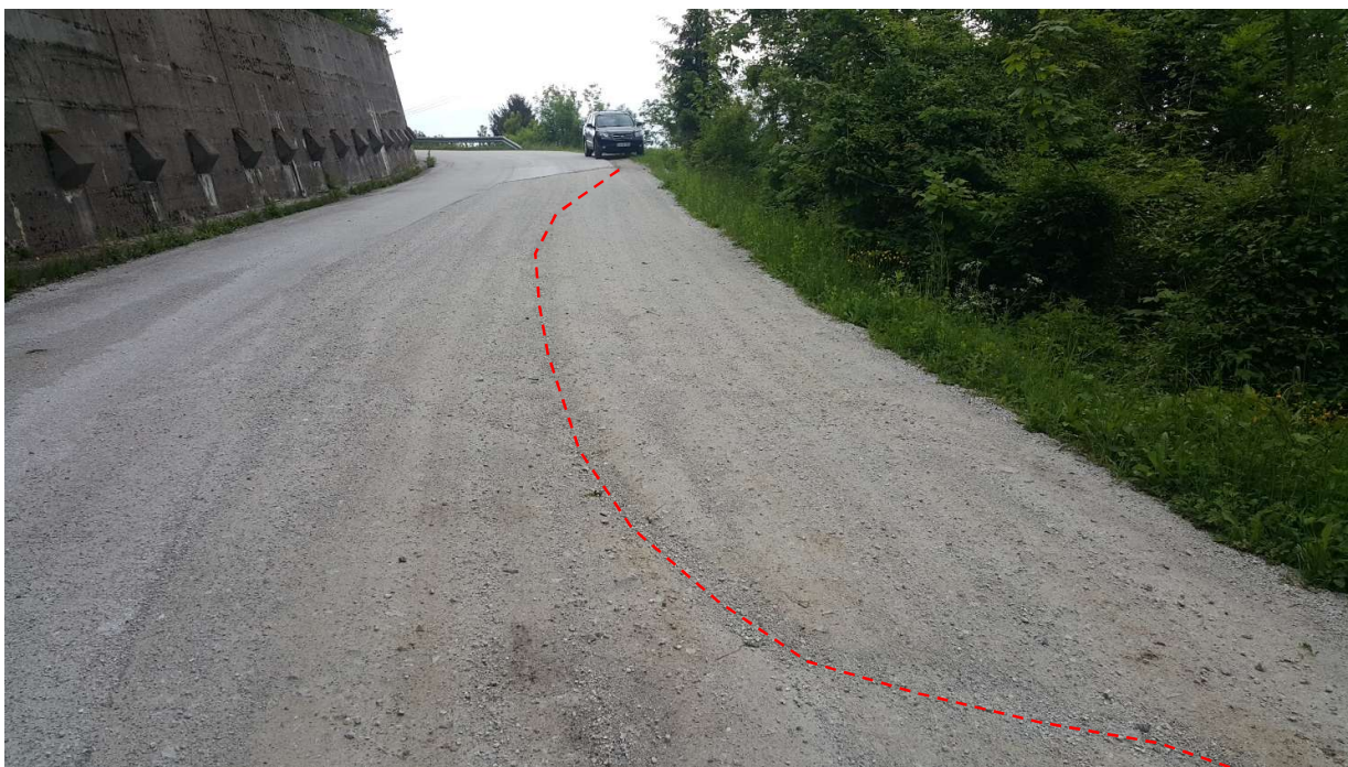
FOTO 1: plaz pod pilotno steno in vidni odlomni rob v nasipu
