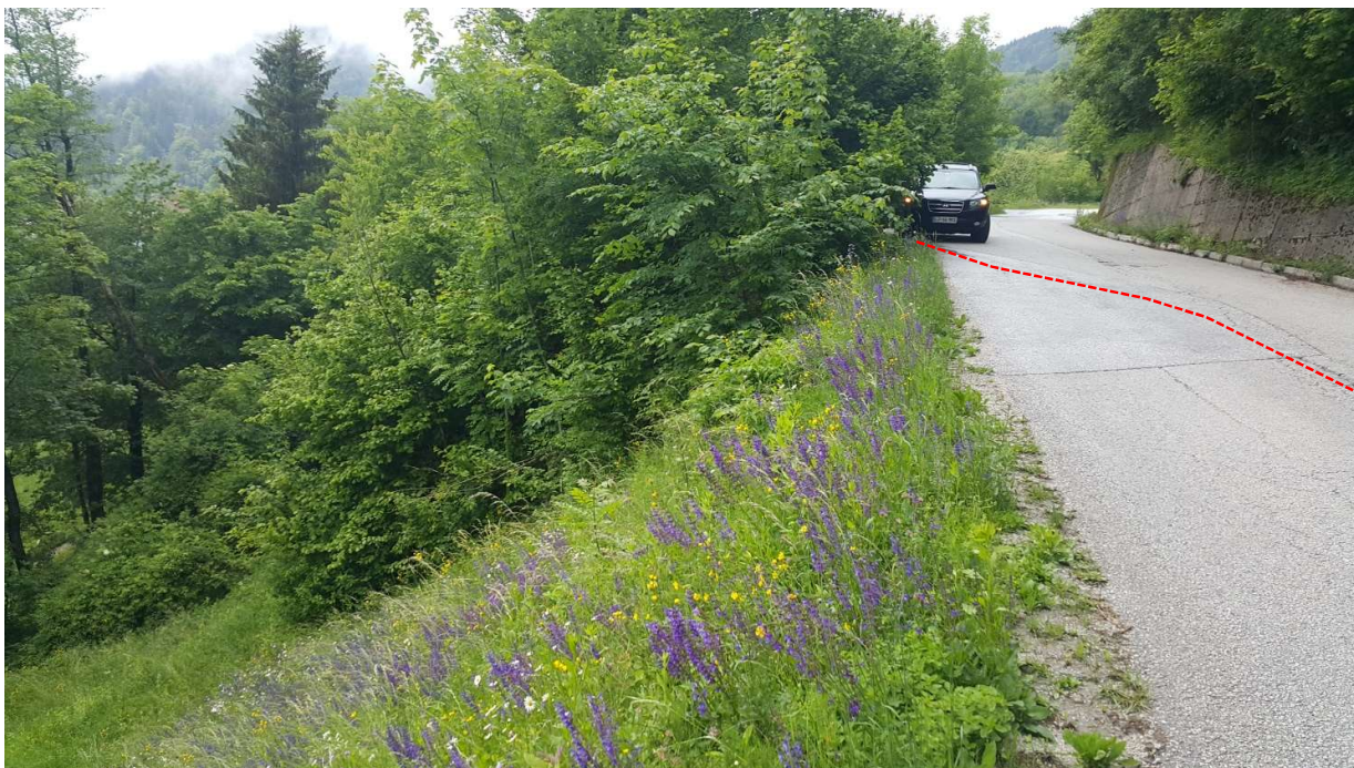
FOTO 6: Plaz 3. Viden odlomni rob v asfaltu. Maksimalen posedek do 20 cm.
