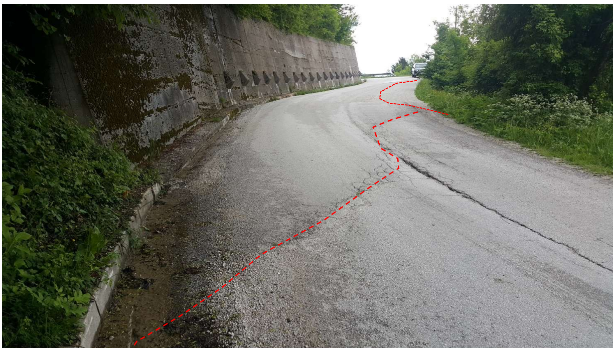
FOTO 2: drug odlomni rob (sekundarni plaz), vidni iztoki vode
